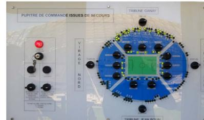
Beispiel einer Konsole zur Schnellsteuerung von Notausgängen
